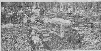
En una región de Guanacaste un **Oliver-Cletrac** operando por medio de la polea trasera un aserradero
